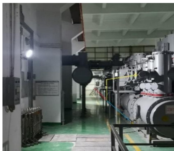
图8 室内无人机巡检路线
