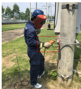
图5 电焊作业场景样张
