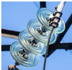
图3 35 kV U70BP/146-1 型绝缘子串
